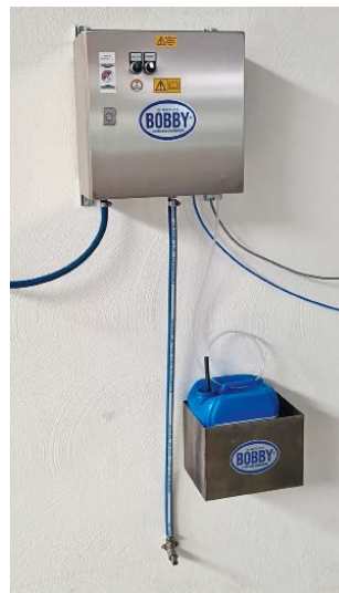
Die Durchgangsdésinfektionsanlage JR-Foam sorgt für einen langanhaltenden Schaumteppich. Bobby/Rettinger
